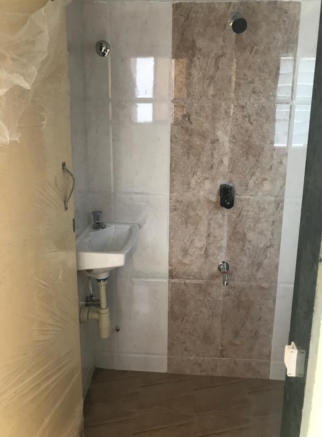
Actual Image of MASTER BED TOILET
